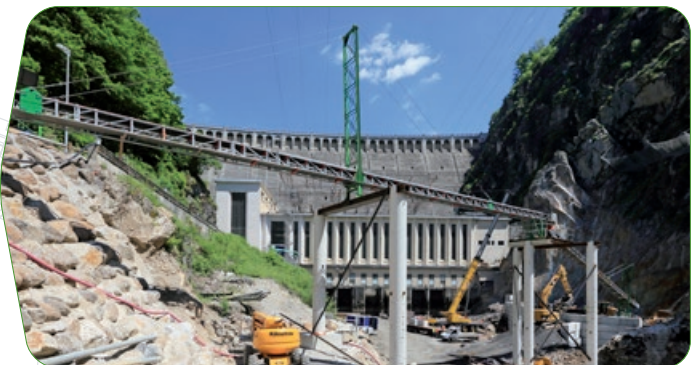
Barrage de Sarrans • Transport de grave-béton
