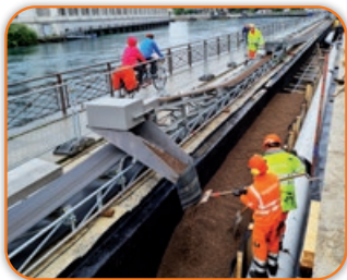
Genève – projet Genilac 600 m de convoyeurs
